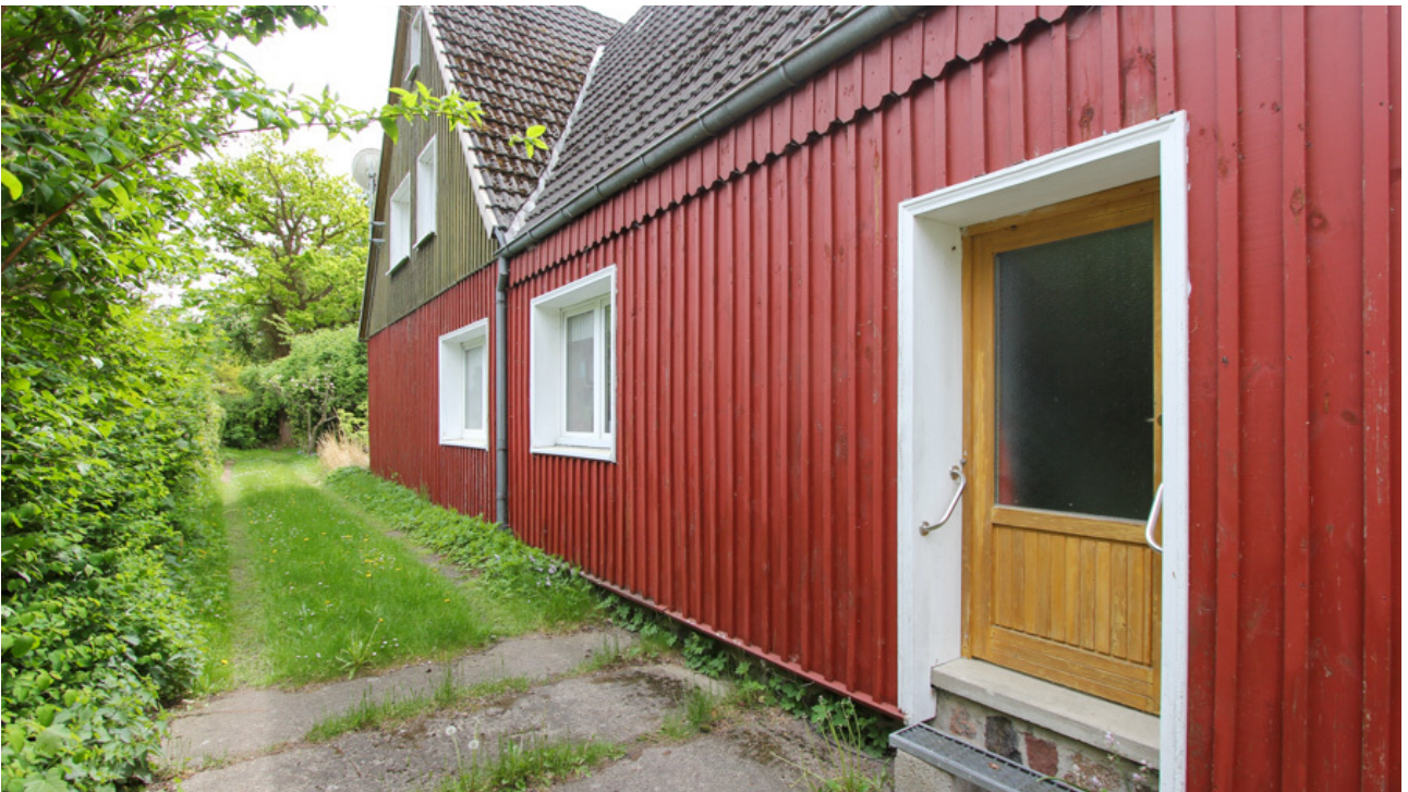
Weg Ostseite Wohnhaus
