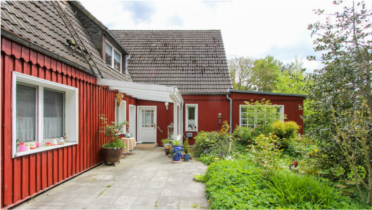
Terrasse Nord-Westen Hauseingang
